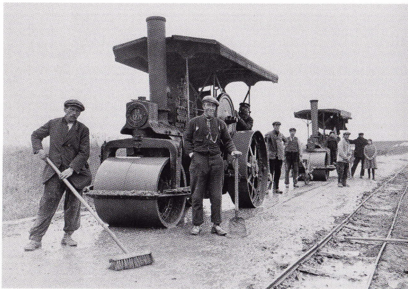
Grondwerkers poseren bij stoomwalsen tijdens de inpolderingswerkzaamheden van een deel van de Biesbosch van 1926 tot 1928. Foto door atelier Schreurs, SAD
